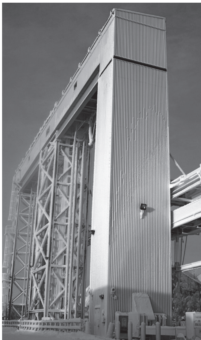
Barrage d'Eastmain 1A situé à La Romaine
