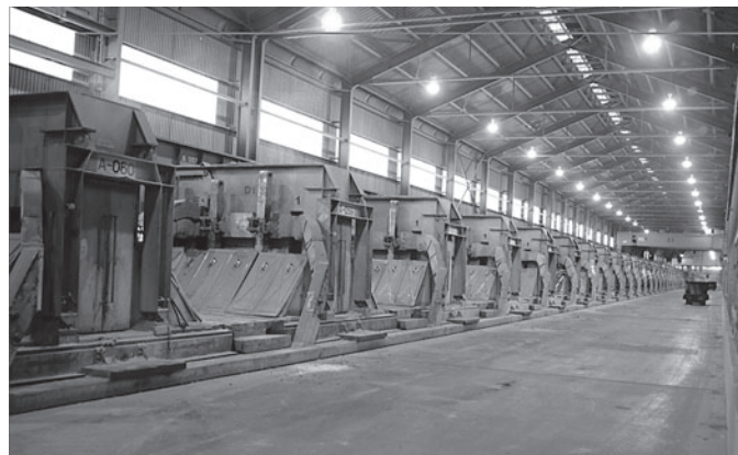
L'aluminium bénéficie grandement de la capacité du Québec de fournir de l'électricité à bon prix. Vue de l'intérieur de l'aluminerie ABI à Bécancour.
