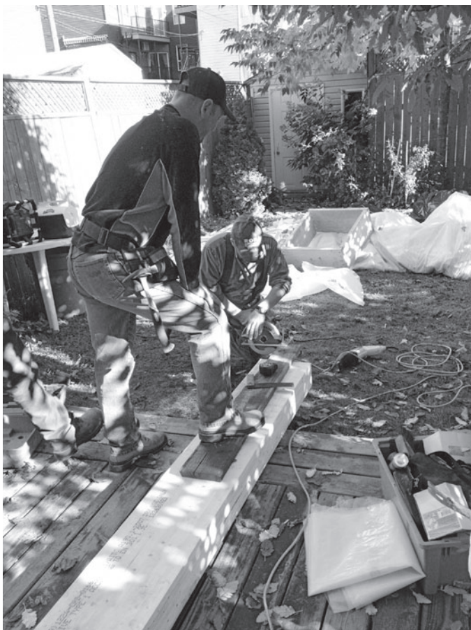
Installation d'une poutre de bois de lamellé-collé, fabriquée chez Chantiers Chibougamau par des syndiqués Métallos
